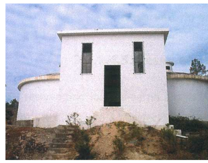
Figura 7.29 – Reservatório de Rasa de Infias
