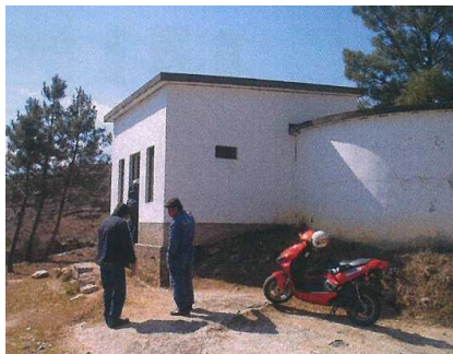
Figura 7.30 – Reservatório de Figueiró da Granja
