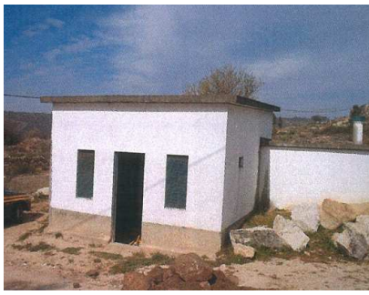
Figura 7.31 – Reservatório de Vila Chã
